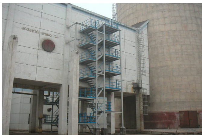
图 2 中国某火力发电厂水平烟道上 CEMS 采样点
